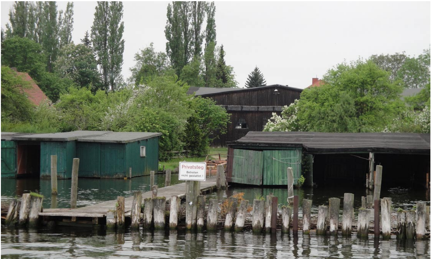
Ansicht von Seeseite © Landeshauptstadt Schwerin
