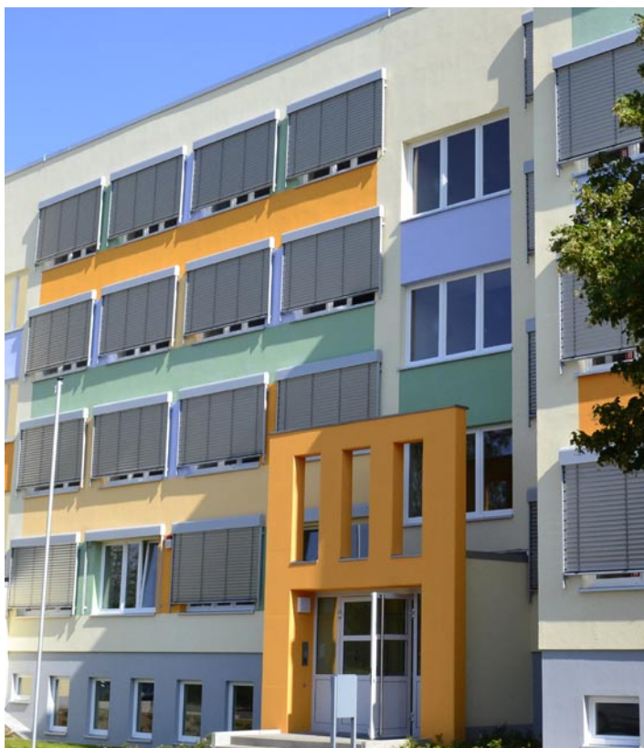
Die Grundschule Mueßer Berg wurde von Grund auf für insgesamt 4,2 Millionen Euro zu einer Ganztagschule mit Hort umgebaut.
