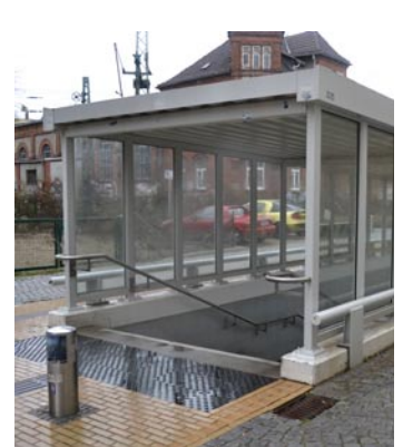
Der Tunnel in der Lübecker Straße
