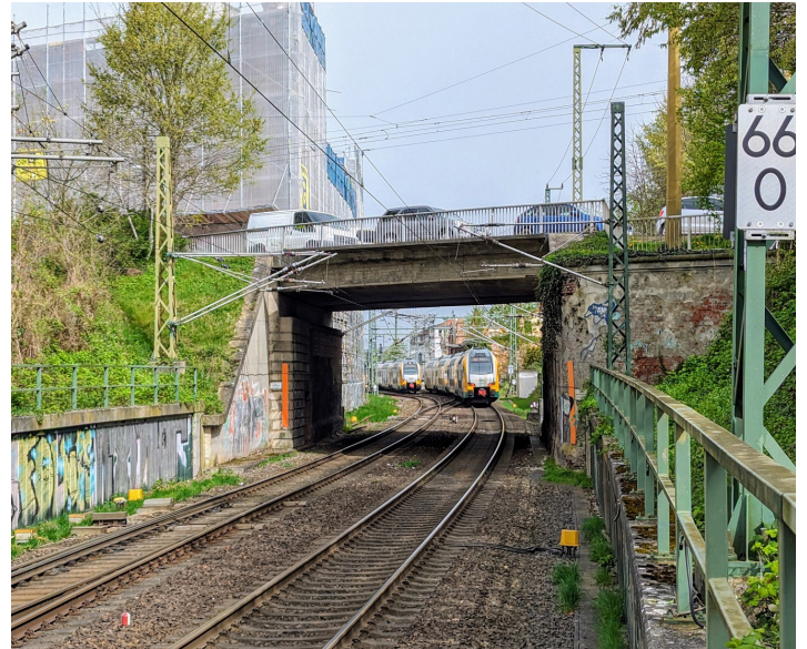
An der Brücke Franz-Mehring-Straße wird die Sperrpause der Deutschen Bahn genutzt, um die Unterbauten instand zu setzen. © LHS/Ulrike Auge
